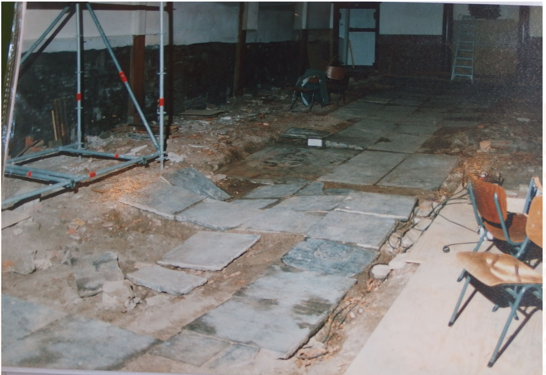
1991 Restauratie St Pieterkerk Grou
